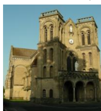
Figure 2.2 : Eglise Saint Charles de Marnaval (Haute-Marne, France) réalisée uniquement en briques de laitier.
